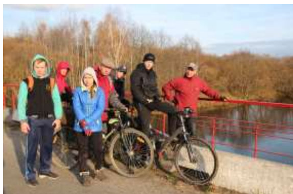
Фото№7 Мост через реку Свислочь в Липене
