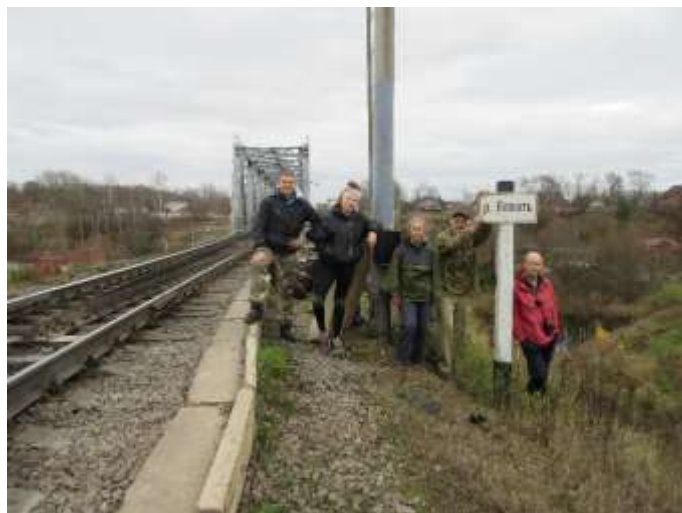
Фото 100. На ж.д. мосту
