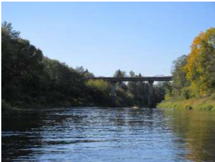
Фото 123. Автомост на тр. Р20-Р17.
