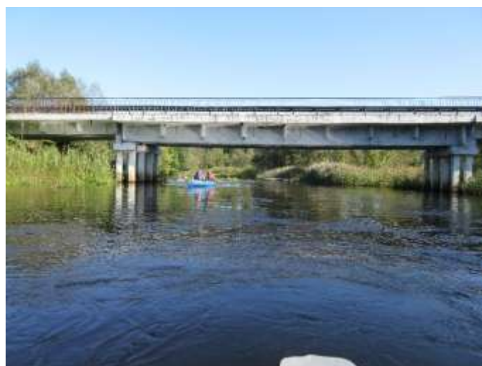
Фото 34. Мост в д.Прудок
