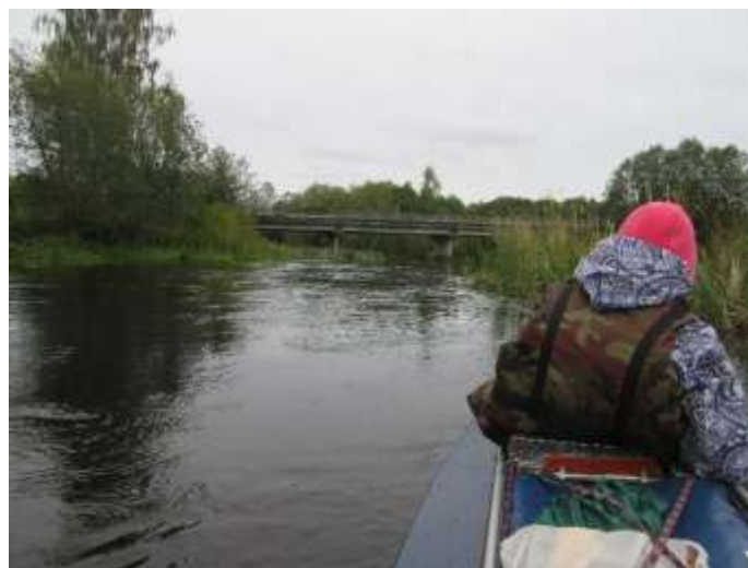
Фото 20. Мост в Краснополье
