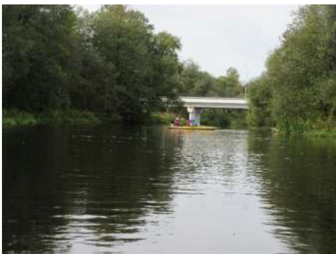
Фото 56. Мост в Янковичах
