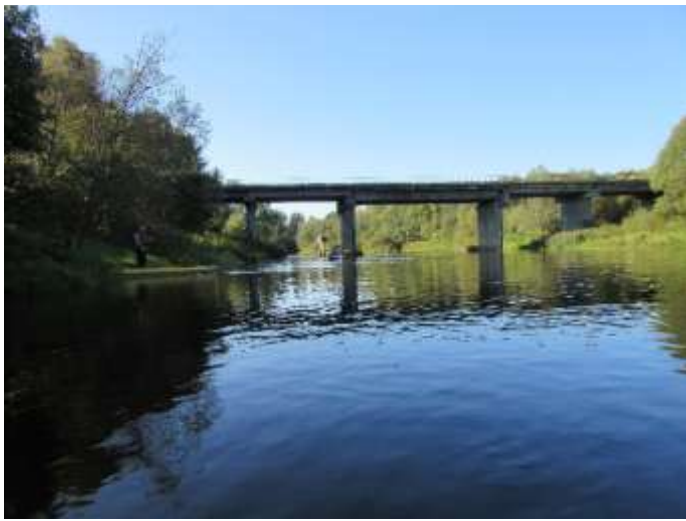
Фото 103. Мост в Дерновичах
