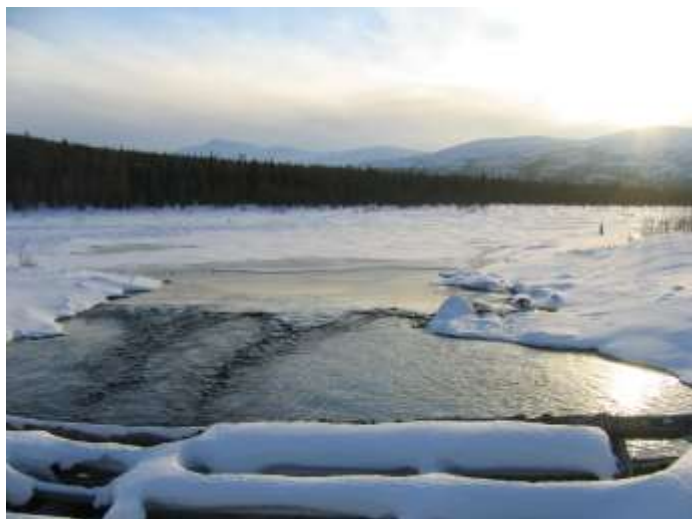
Фото 71. Вид с моста
