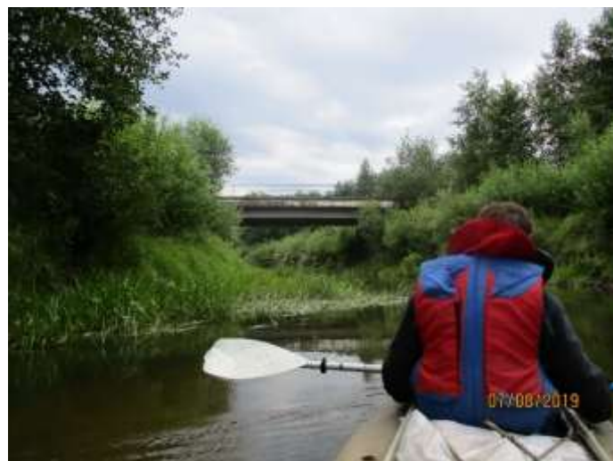
Фото 105. Мост у д.Юзефово
