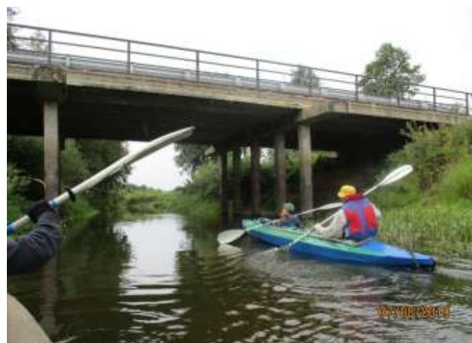
Фото 103. Мост в д.Долгое
