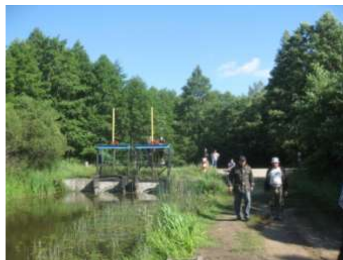
Фото 88. Шлюз в устье р.Смолка
