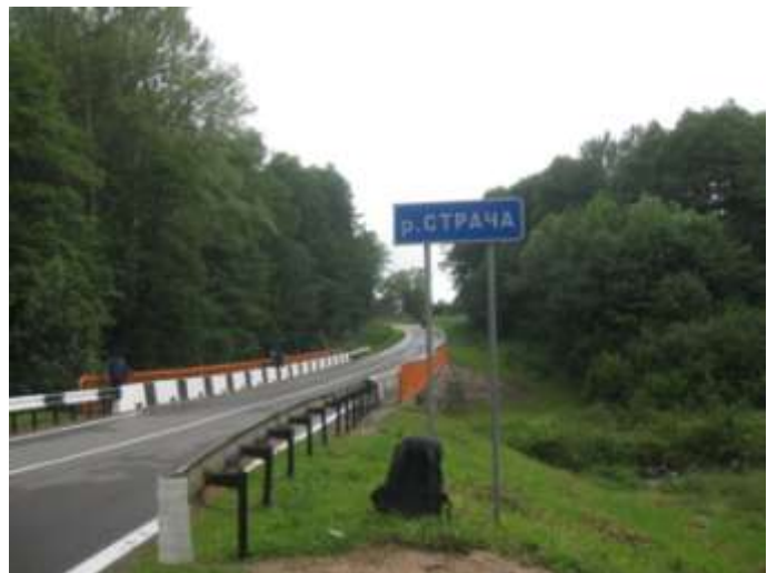
Фото 124. Мост через Страчу
