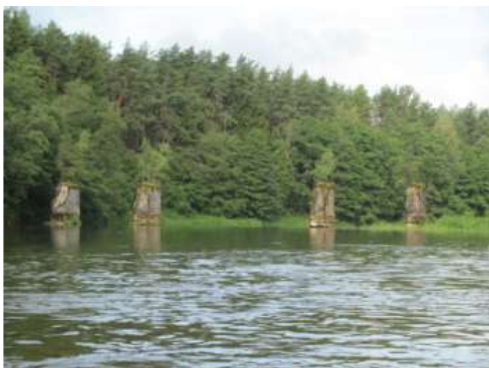
Фото 67. Опоры старого моста
