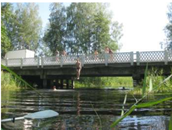
Фото 17. Автомост у д.Черемшицы
